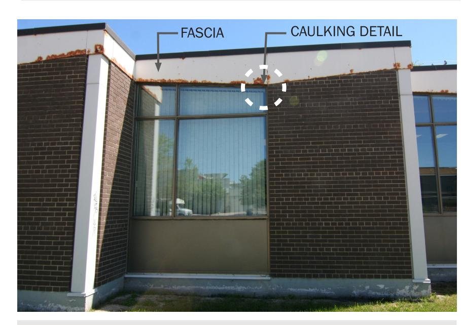
TYPICAL WINDOW DETAIL AT NORTH ELEVATION
